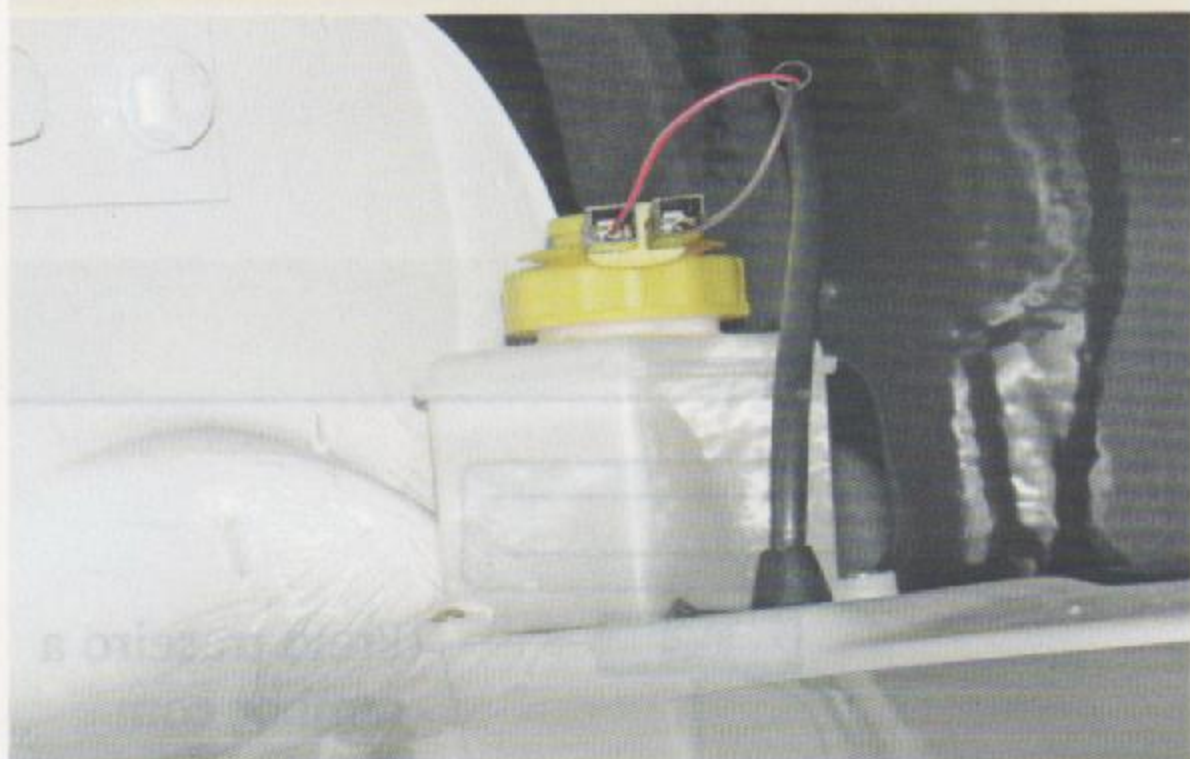
Local de abastecimento do cilindro mestre
