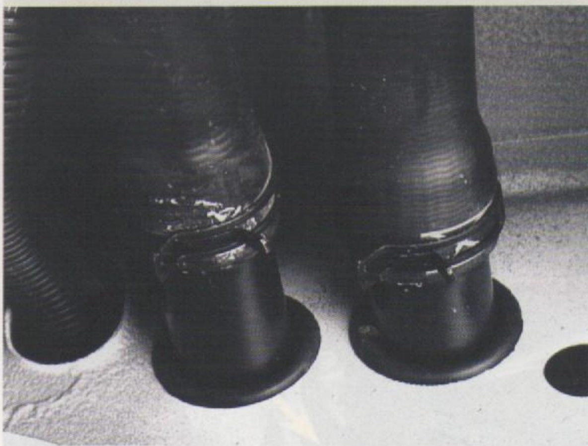
Fig.12 - Verificação de vazamentos nas conexões
