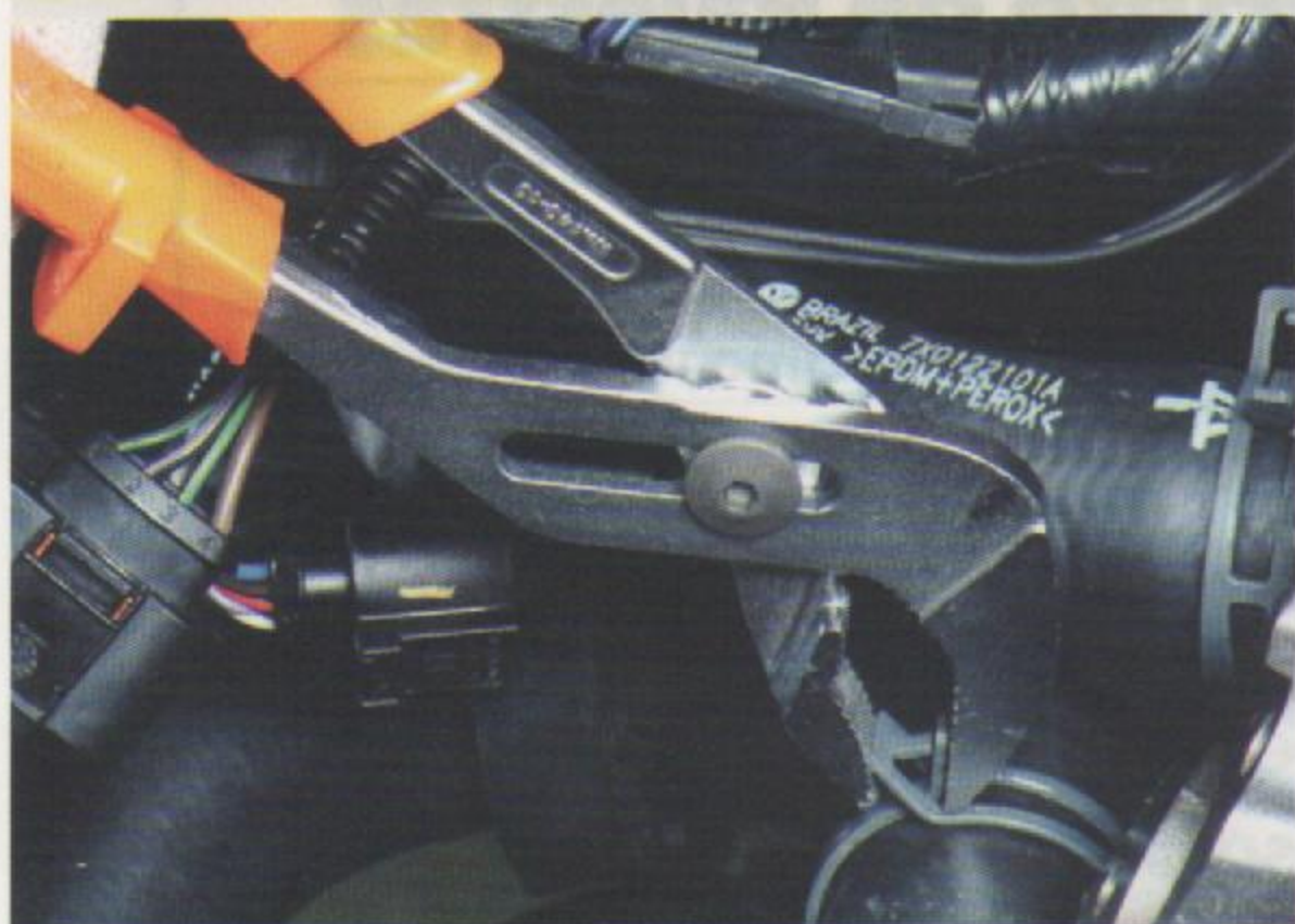
Fig.6a - Remoção da abraçadeira de fixação
