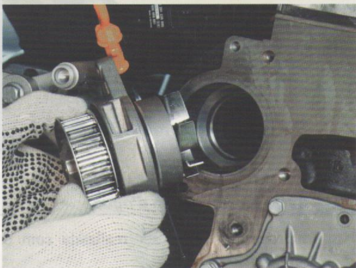
Fig.6 - Remoção da bomba d'água
