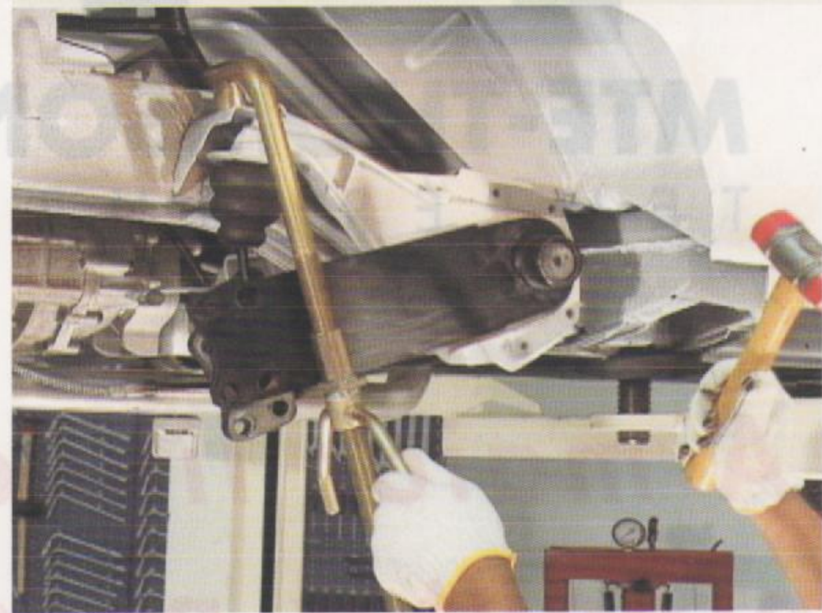
Fig.10 - Assentamento da barra de torção
