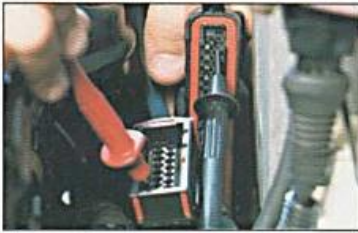
Fig. 3.1. Exemplo de verificação de continuidade no chicote do relé duplo (entre os bornes 1 do relé e 35 do MC).
