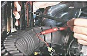
Fig. 4.1. Exemplo de verificação da continuidade no chicote do TPS (entre os bornes 2 do sensor e 14 do MC).
