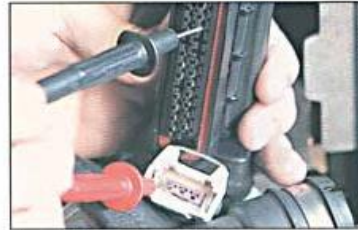
Fig. 2.1. Exemplo de verificação de continuidade no chicote do sensor ESS (entre os bornes 1 do sensor e 28 do MC).
