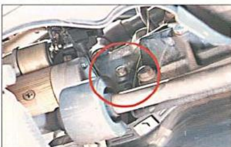
Fig. A. Localização do sensor KS, fixado no painel corta-fogo do compartimento do motor.
